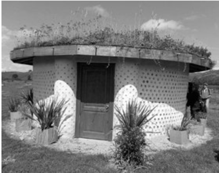
Figura 1: Prototipo de edificación con botellas construido por Organismo en Tenjo- Cundinamarca
