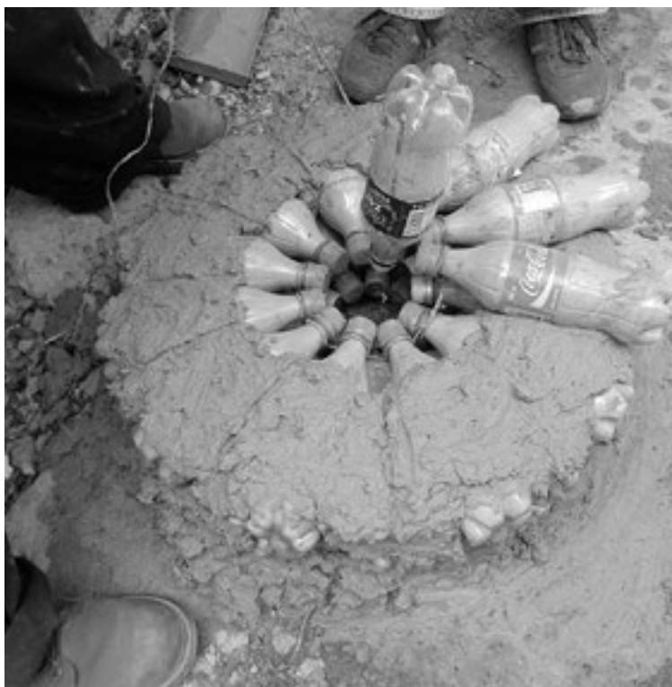
Figura 4: Construcción de columnas. Fotografía: Cecilia López Pérez
