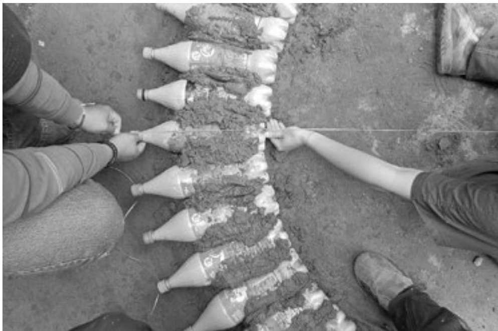
Figura 5: Proceso constructivo de un tanque de agua. Fotografía: Cecilia López Pérez
