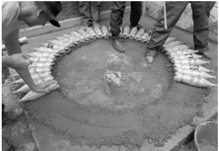
Figura 5: Proceso constructivo de un tanque de agua. Fotografía: Cecilia López Pérez
